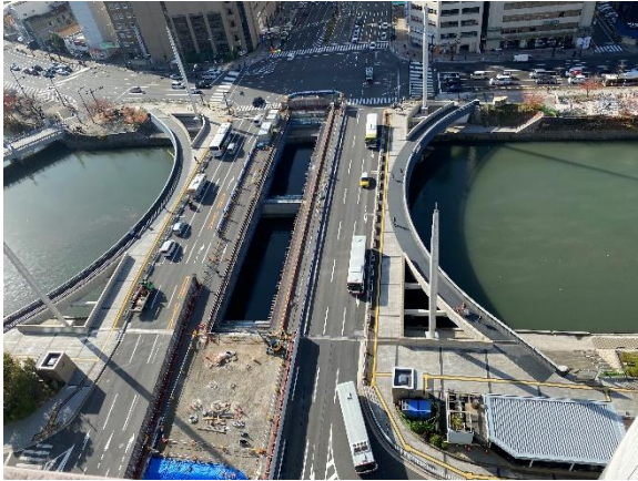
駅前大橋の改修作業
