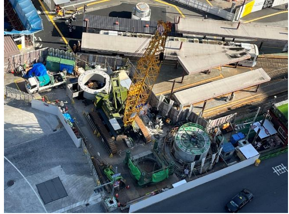
路面電車高架基礎工事
